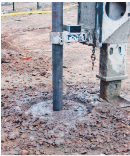
Bild 3: Installation av provpålar och intrimning av systemet.
