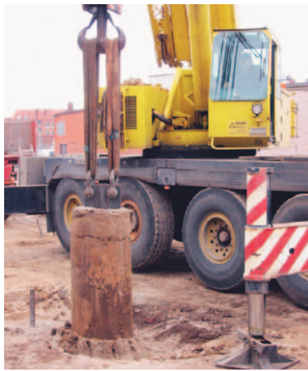
Bild 4: Pågående uppdragning av MDM-påle. Ett Gewi-stag med diametern 63,5 mm trycktes ned i pålen direkt efter installation. Efter sju dagars härdning kunde pålen dras upp med hjälp av fästblock i Gewi-staget.
