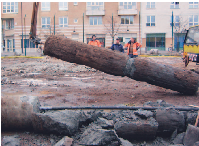
Bild 8: Uppdragning av MDM-pålar efter sju dygns härdning och rekonsolidering. I förgrunden syns den sju meter långa pålen som gick av vid fällning till horisontellt läge. I bakgrunden pågår fällning av den 4,5 meter långa pålen som höll.
